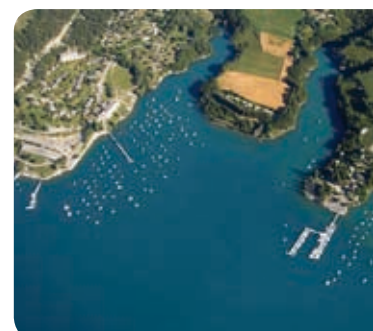
4. Les équipements portuaires sur le lac de Serre-Ponçon sont engagés dans un diagnostic « Ports propres ».
