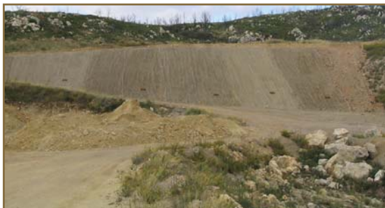
Mise en place du dispositif expérimental
