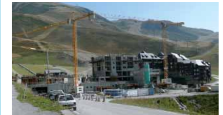
Construction en très haute performance énergétique du complexe multi-activités de la station de ski de Peyragudes (65)
