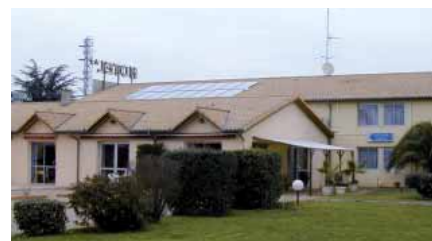
Installation solaire thermique sur le toit de l'hôtel Thib'hôtel à Toulouse (31)
