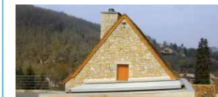
Chaufferie-bois de Nuzéjols (46)
