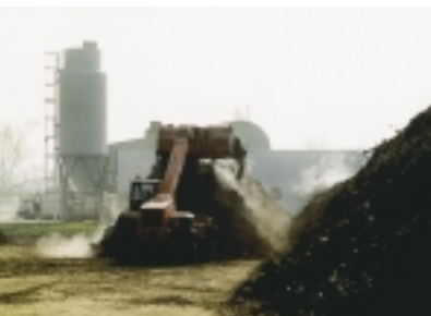
plate-forme de compostage de Cugnaux (31) source ADEME
