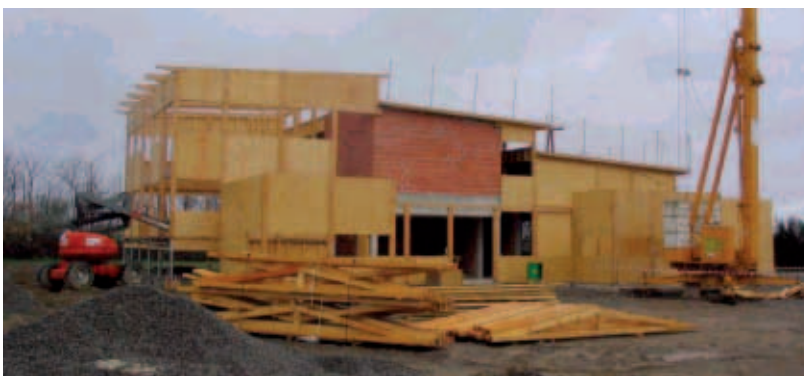
Construction du bâtiment
