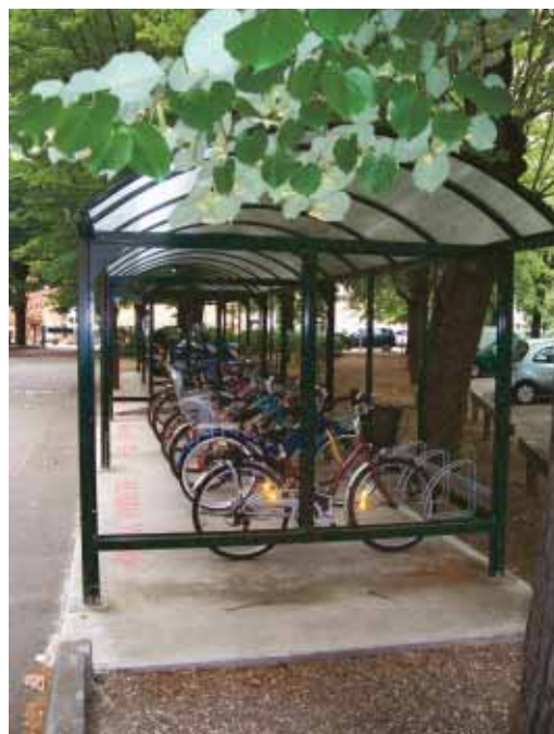
Extension du garage à vélo
