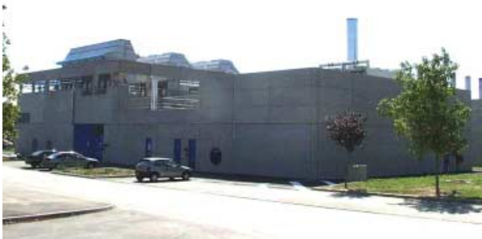
Centrale de trigénération du CNES
