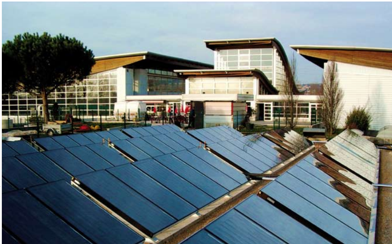
La piscine de l'Archipel à Castres (81) équipée de capteurs vitrés.
