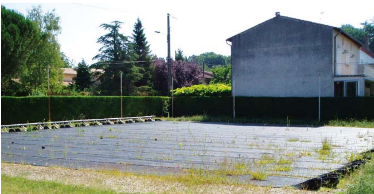
La piscine Bisséous à Castres (81) équipée de capteurs souples.
