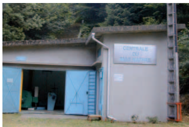
Centrale hydroélectrique du Mas Naffre à Saint-Amans Soubert (81)
