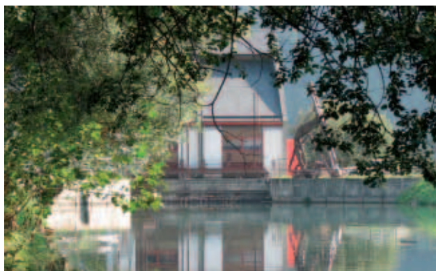
Centrale hydroélectrique des Couscouillets
