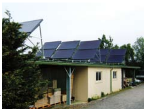
La nouvelle installation solaire thermique de 42 m 2 de capteurs.
