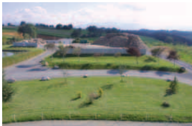
Déchèterie de Lannemezan (65): plateforme de valorisation des déchets de bois et casier réservé aux déchets d'amiante
