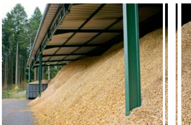
Chaufferie au bois de Rosheim : stockage de la plaquette forestière
