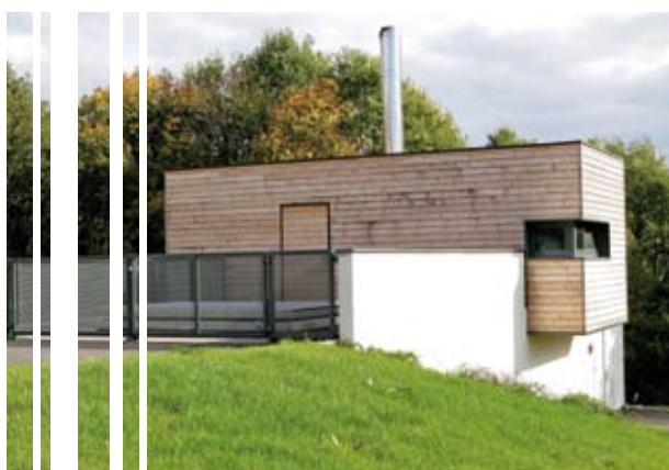
Chaufferie au bois de la Petite Pierre
