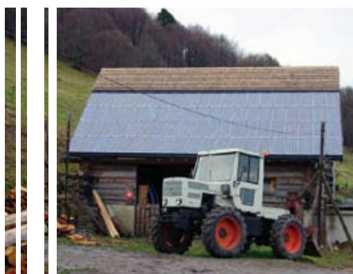
Installation photovoltaïque de la Ferme Auberge du Gsang
