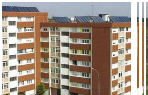
Installation solaire CUS Habitat à Ostwald
