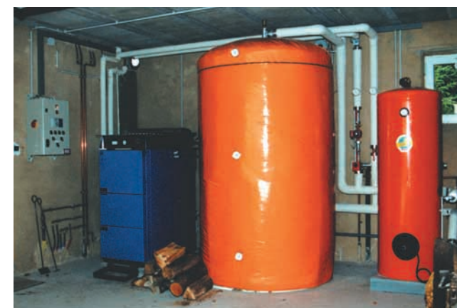
Vue d'une chaudière bois à hydroaccumulation
