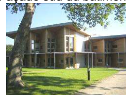
Façade sud du bâtiment
