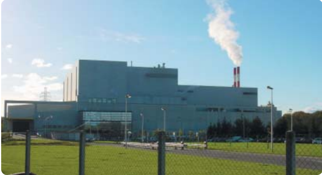
Usine d'incinération d'ordures ménagères de Sausheim. NB : le panache blanc de fumée est constitué de vapeur d'eau. Source : ADEME
