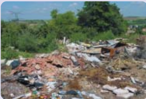
Décharge brute avant travaux de remise en état. Source : ADEME
