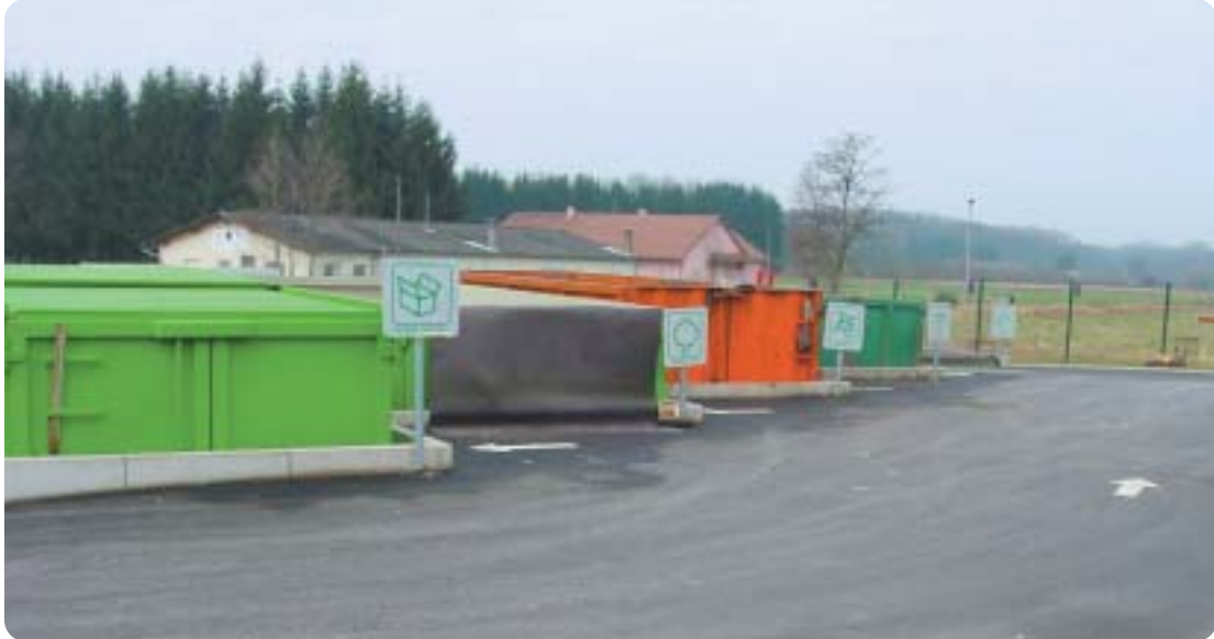
Exemple de déchèterie Bas-Rhinoise. Source : ADEME
