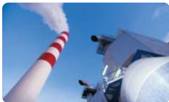
Usine d'incinération d'ordures ménagères de Strasbourg. Source : ADEME
